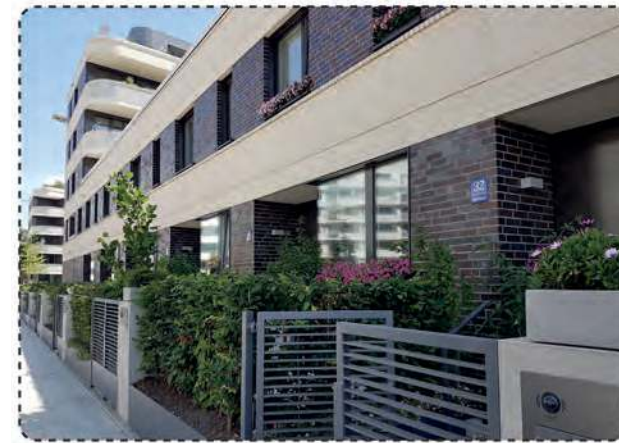
Erdgeschosszone | Baumkirchen Mitte München, CA IMMO
